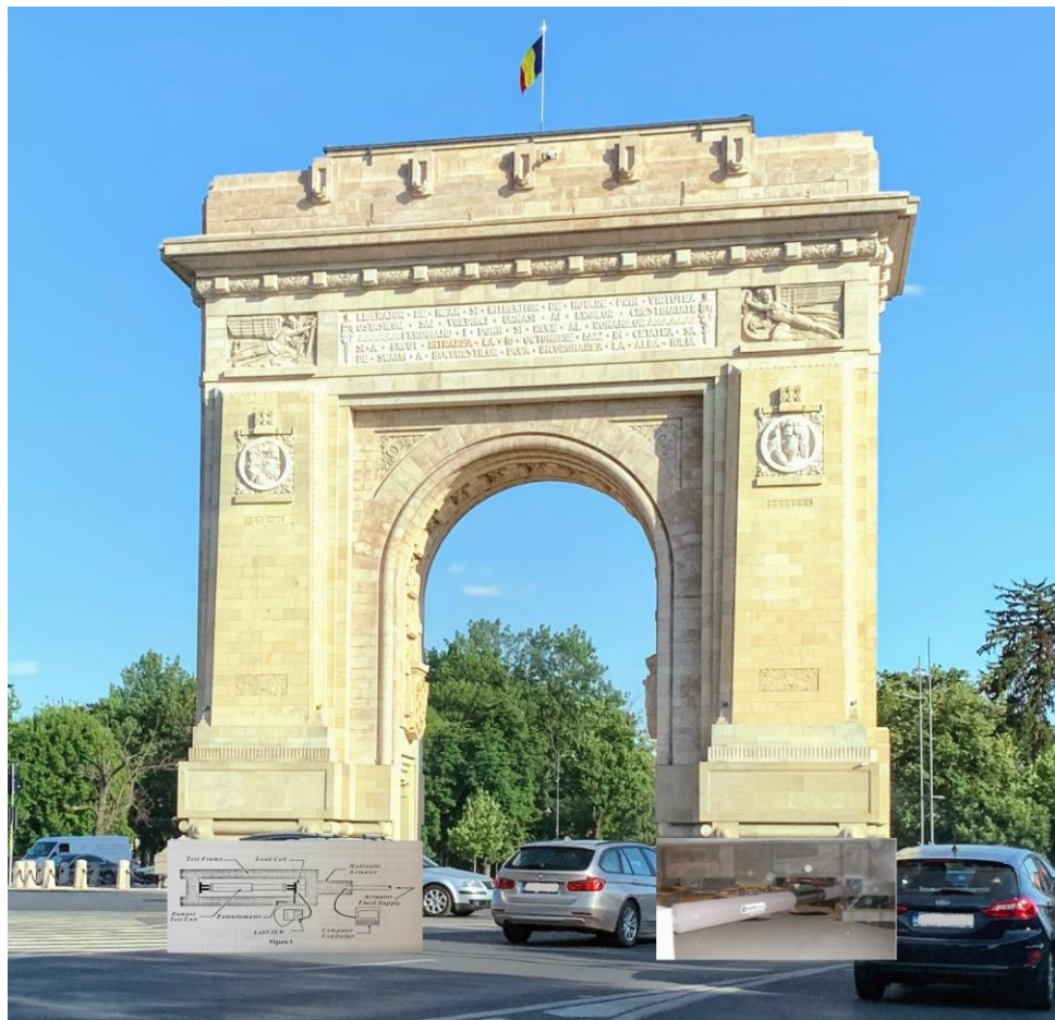
Fig. Montarea unor amortizori antiseismici la Arcul de Triumf – București
